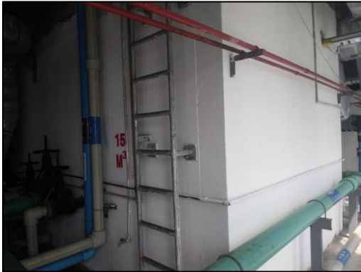
รูปที่ 10 ถังเก็บน้ำในโครงการ
